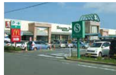
しずてつ掛川ショッピングセンターS-PLAZA 掛川市上西郷
