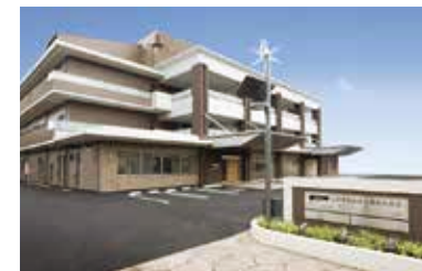
グライフ北安東 静岡市葵区北安東
